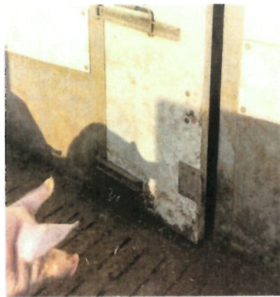
△ Die Schweine können das untere Türelement an der Metallplatte von außen öffnen.
