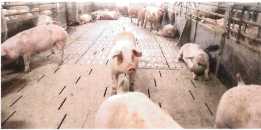
△ Vorne ersetzen Komfortplatten den Spaltenboden, hinten verdeckt Gummi die Schlitze.
